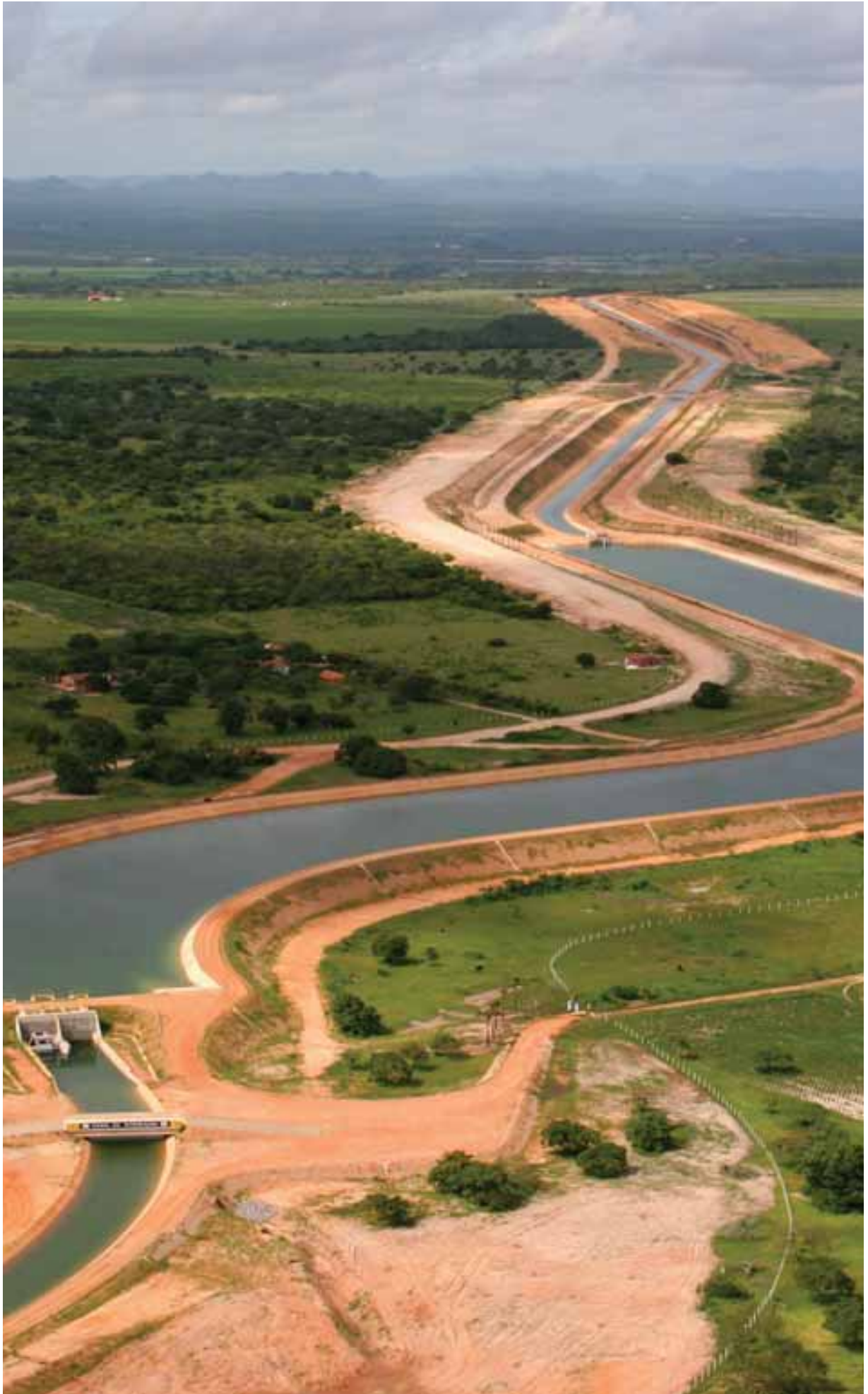
Trecho do Canal da Integração
